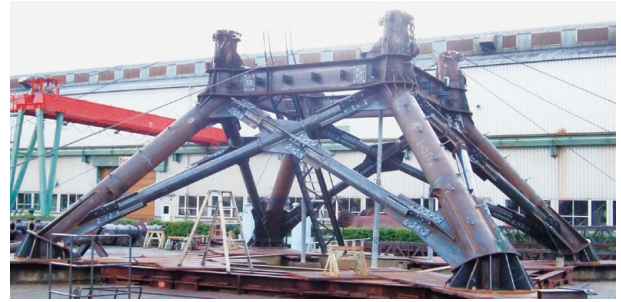
写真1 最下節写真(建物との連結部)
